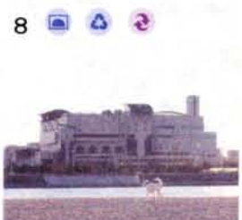
8 西部総合処理センター
